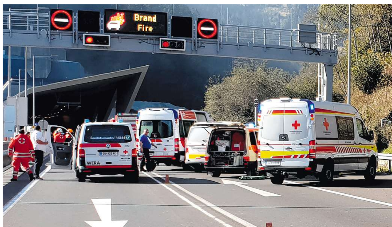
Ein als Sondertransport deklariertes Sattelschlepper fing im Gleinalmtunnel einen Kilometer vom Südportal entfernt Feuer
